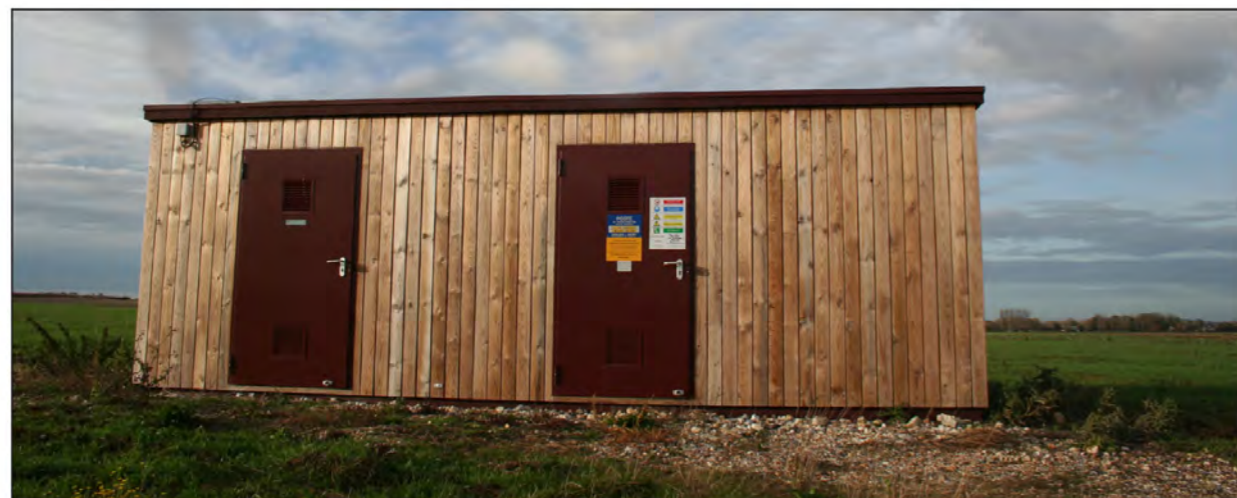
Exemple-type de poste de livraison
